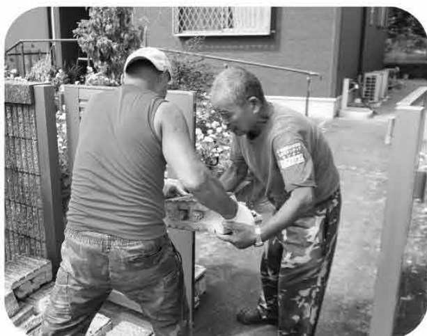
壊れたブロック塀の運搬の様子
