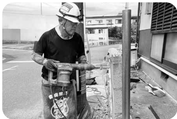
壊れたブロック塀の解体を専門技術で支えてくださった、福岡県のボランティア団体「決断」の武田さん 遠く福岡から駆けつけてくださいました
